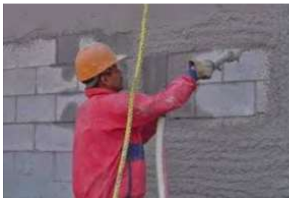
Fig. 2. Lanzamiento de mortero premezclado
