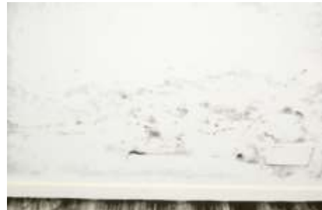
Figura.2. Manchas en Pared con Problema de Humedad por Capilaridad de la Residencia Tapia García
